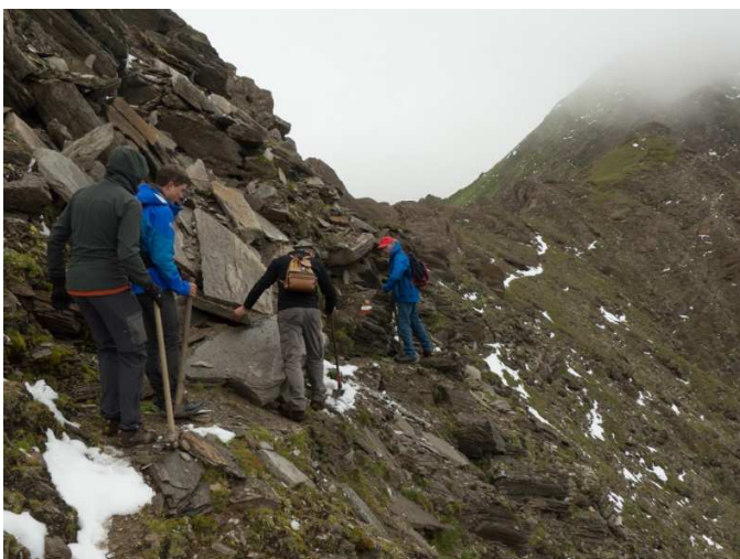
Arbeitseinsatz am Westerfrölke-Weg.
